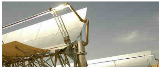
Els espills concentren la llum solar en un tub de cristall per on circula oli.
