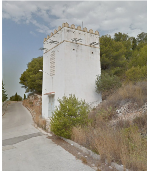
Caseta centre de transformació Santa Llúcia, a Xàbia.
