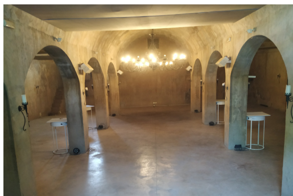
Aljub construït per a abastir d'aigua potable Ondara, 1930. Fotografia: ENRIQUE BOLUDA
