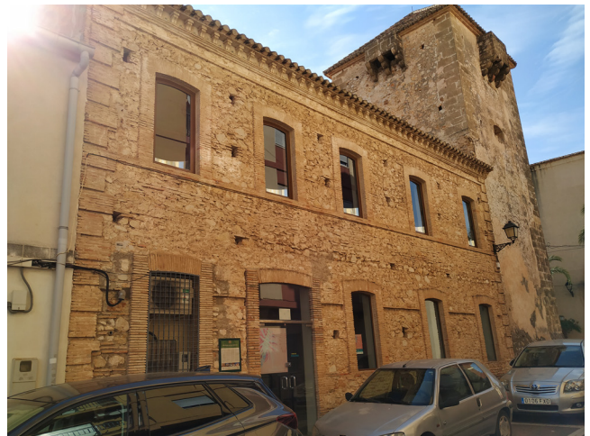
Centre de transformació del Verger (al voltant de 1910). Fotografia: ROBERT MIRALLES
