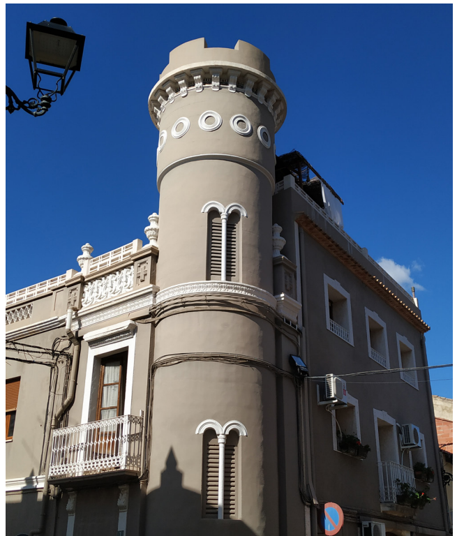
Transformador del carrer Luís Santonja, Beniarbeig, anys 20. Fotografia: ROBERT MIRALLES
