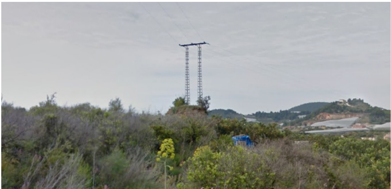
Columna en la línia elèctrica Callosa-Xaló.
