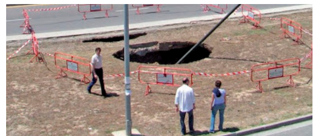
Dolina. Autovia de Logronyo a Saragossa.
