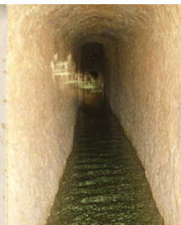
Cava o galeria subterrània.
