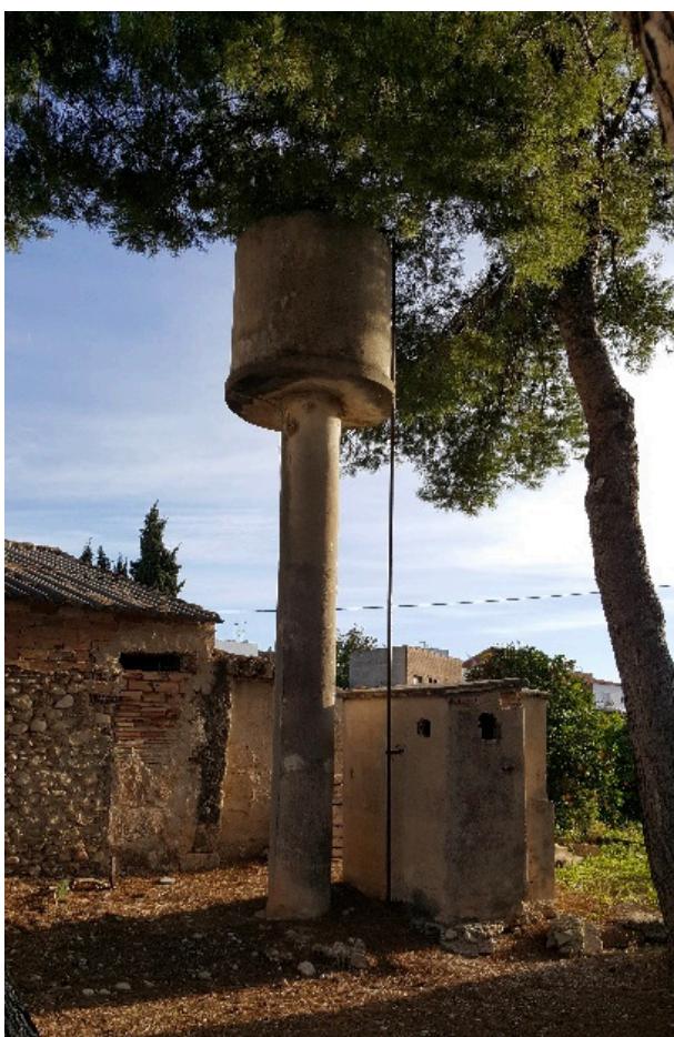
Llavador obert de Sanet i els Negrals a la séquia de la Cava del Ràfol. Dipòsit que, des del pou de l'Estanquer, donava l'aigua a les escoles antigues de Mirafior, en l'actualitat.
