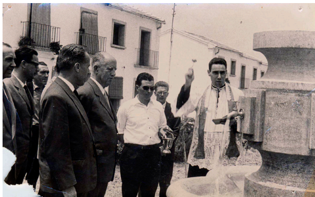
Inauguració oficial de la xarxa d'aigua potable a la font de les quatre aixetes en 1960. Font pública al carrer de Baix al voltant de 1965.
