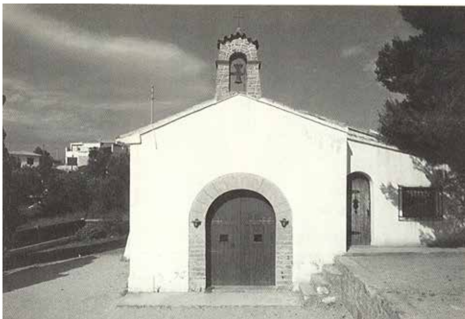
Ermita de Sant Joan, 1960 (Arxiu Històric Municipal de Dènia). Habitualment utilitzada com a llatzeret al llarg del segle XIX, fonamentalment per a l'aïllament dels malalts.
