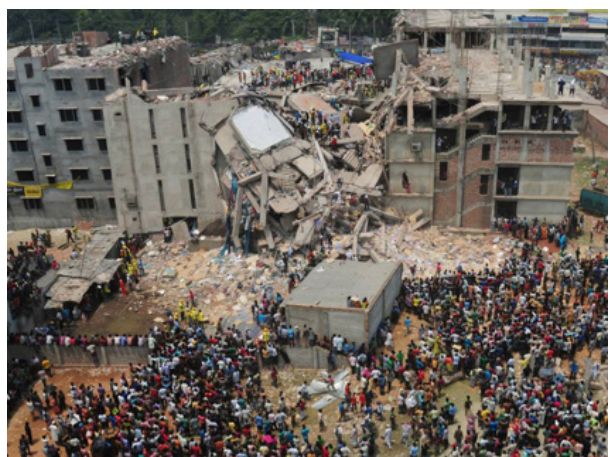
Esfondrament de l'edifici Rana Plaza Bangladesh 2013. El País
