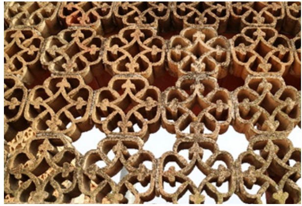
Barana de gasparilles d'un terrat.
