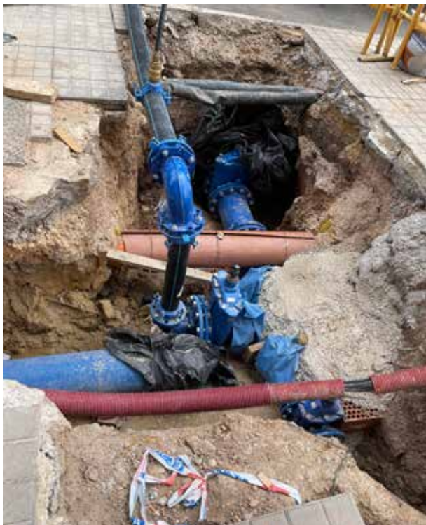
Figura 3. Detall de les instal·lacions trobades sota la vorera en una obra de reparació d'aigua potable. Els tubs blaus i els que connecten amb les peces blaves són d'aigua potable, mentre que els que estan més prop de la superfície són tubs de protecció per a cables elèctrics.
