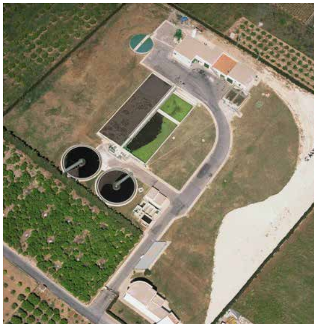
Depuradora de Xàbia. EPSAR.
