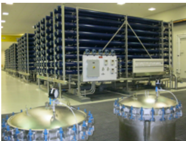
Tren de producció dessaladora per osmosi inversa. Per Twhair (Treball propi, CC BY-SA 4.0, https://commons.wikimedia.org/w/index.php?curid=36829194 )
